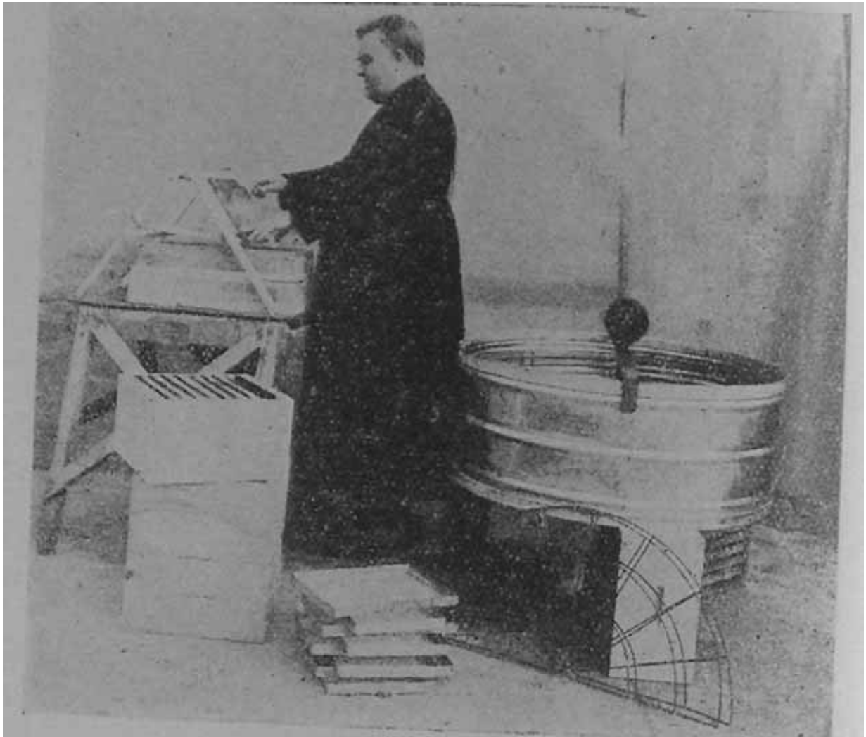
8°. L'opérateur désopercule une face du rayon.
